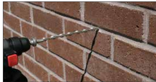
Heli-Tie™ Helical Wall Tie
